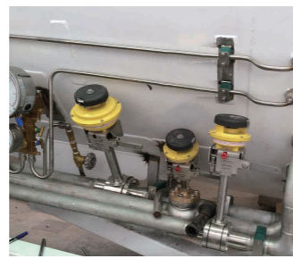
FBV4 阀门在LNG罐箱应用
